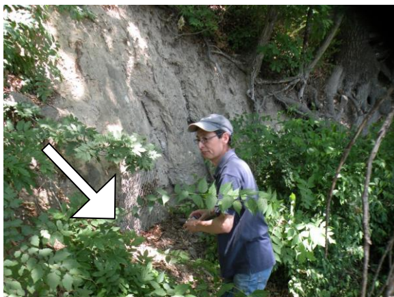
擁壁の内側に冷風穴の横穴があった！
