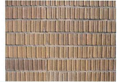
創建時の外壁タイル
