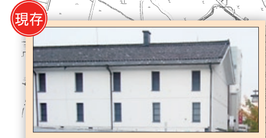
上田倉庫・諏訪倉庫 銀行家と上田・丸子の製糸業者によって設立された最初の営業用繭倉。(現みずびと館(飯島商店))
