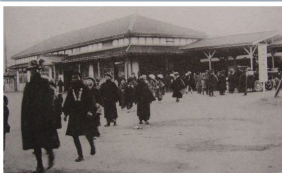
明治42年(1909)改築の上田駅
