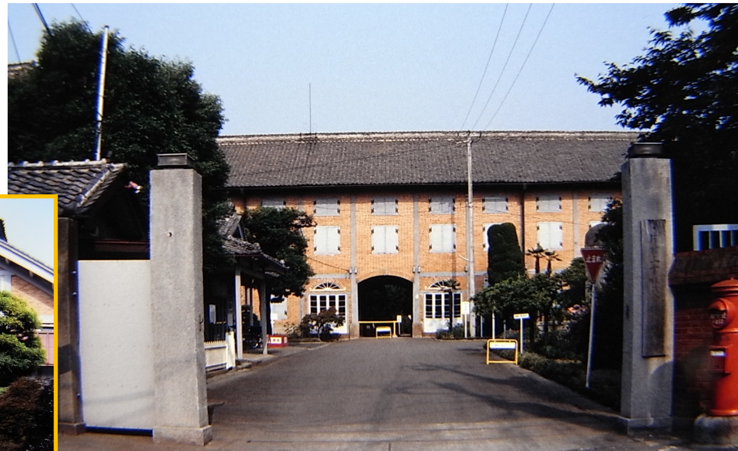
正門からの繭倉庫
