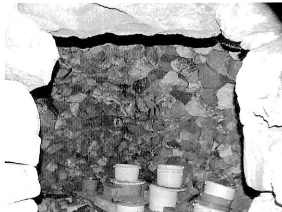
笹平風穴、炭焼き窯構造珍しで珍しい、天井はドーム構造！
