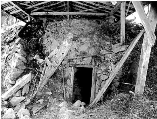
笹平風穴、炭焼き窯構造珍しで珍しい、天井はドーム構造！
