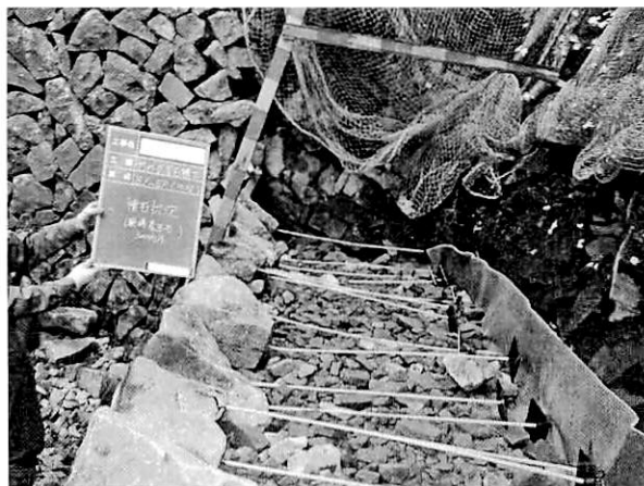
「アンカー式空石積工」 左から積石・アンカー・裏込め礫・ストッパーパネル・ 吸い出し防止シートの構造
