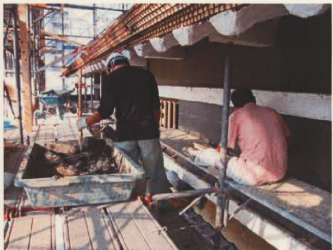
外壁中塗り状況
