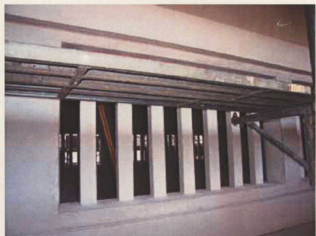
窓廻り砂漆喰仕上がり状況
