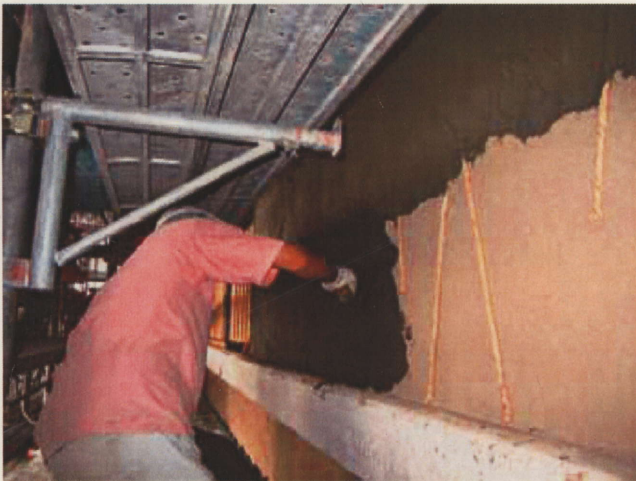
外壁小斑直し状況
