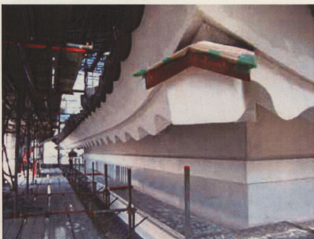
外壁砂漆喰仕上がり状況
