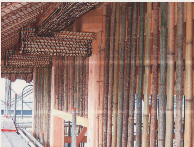
縦間渡し竹取り付け終了
