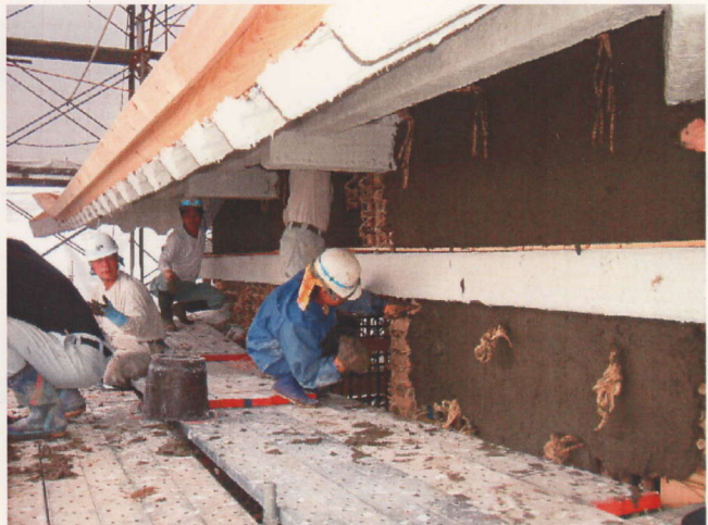
荒壁施工状況
