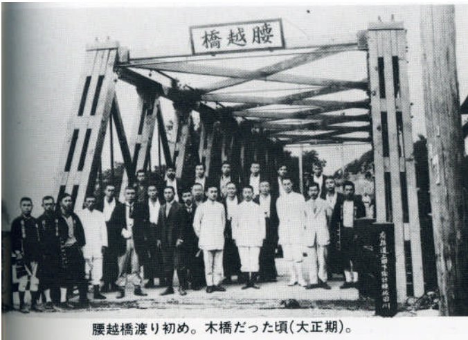
写真-20 和田-大屋間の道路にある腰越橋(大正の改修、ハウトラス形式の木鉄橋。明治時代に既に馬車が通れる橋だったとみられる。)
